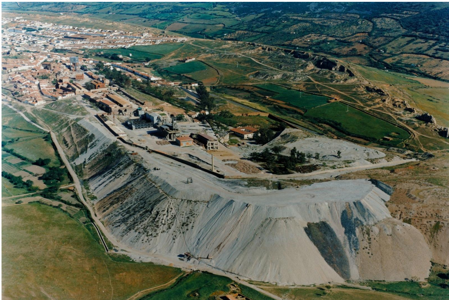
ESCOMBRERA DEL CERCO DE SAN TEODORO AÑO 1967
