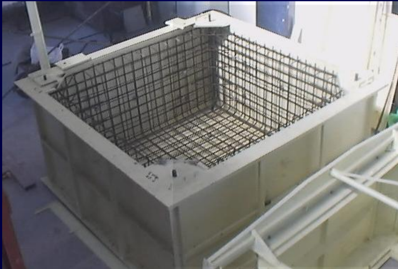
Molde. Paredes externas y armadura
