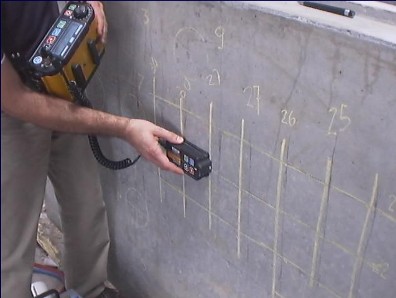
Determinación del espesor de recubrimiento
