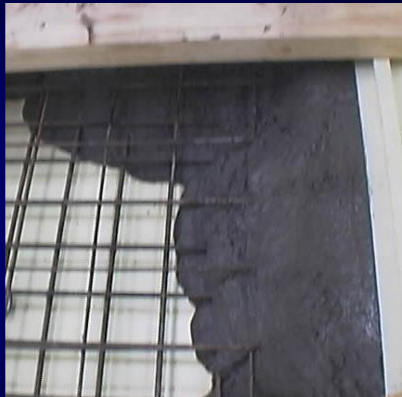
Avance del hormigón en el fondo
